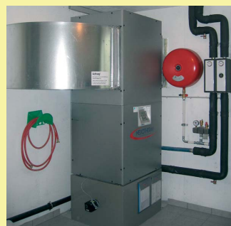
Wärmepumpe
